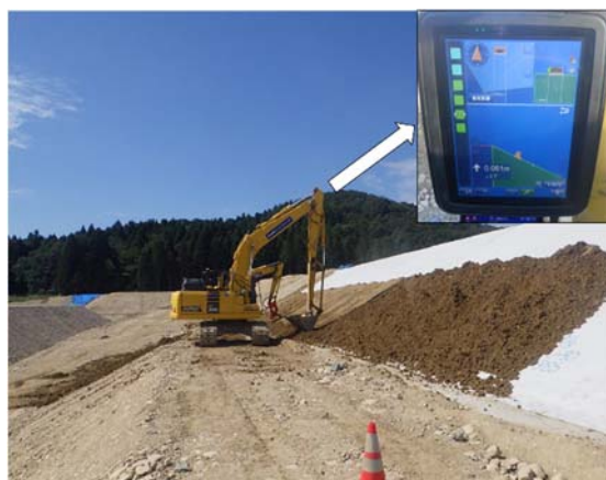
写真2 ICT 建機による法面整形
